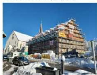
Der ehemalige Brauereigasthof Sonne in Heimenkirch wird umgebaut (Foto 03.12.2023)
