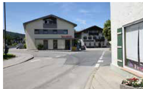
Abb. 69: Sparkasse u. Metzgerei (rechte Gebäudeseite)
